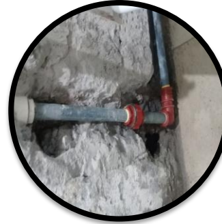
Baños(Fugas de agua y limpieza de corrosión de acero inoxidable)
